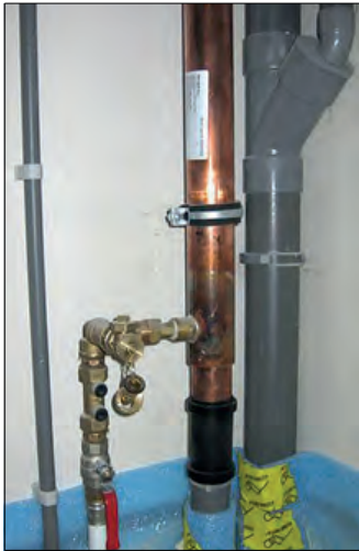
De douchepijp dient makkelijk toegankelijk te zijn
