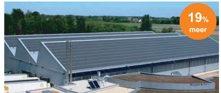
FR, Bourgogne-F.C. / 429,9 kWp
