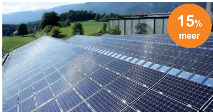
CH, Solothurn / 224 kWp
