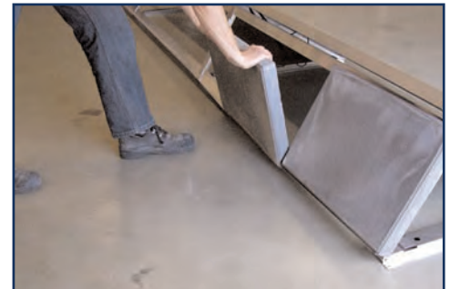
9. Plaatsen van de ballast
