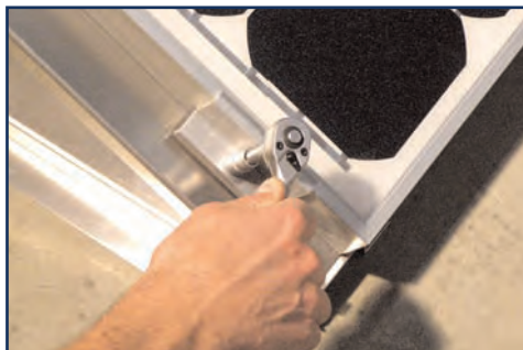
7. Montage van het eerste paneel
