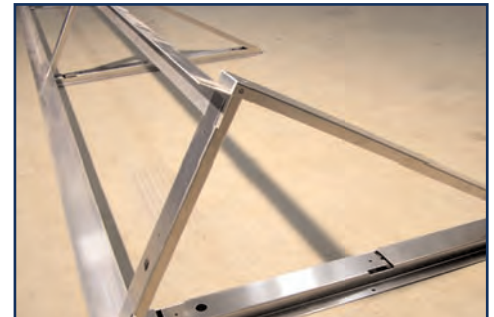
6. Plaatsen tweede aluminium profiel
