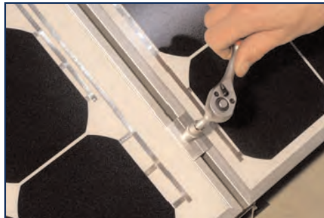
8. Montage van de volgende panelen
