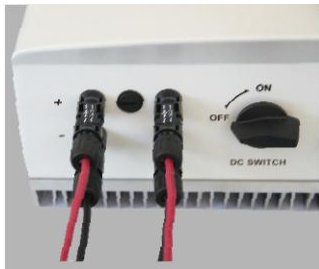
▲ Figuur 4.10 Sluit de DC-connectoren op de omvormer aan
