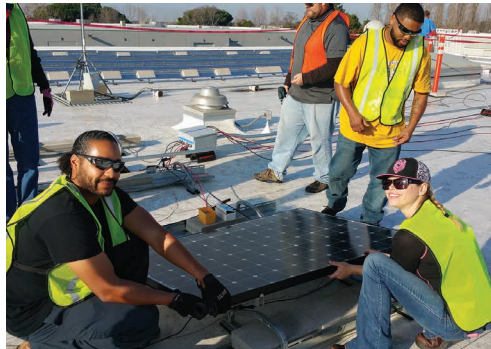
Teamwork voor een dakinstallatie
